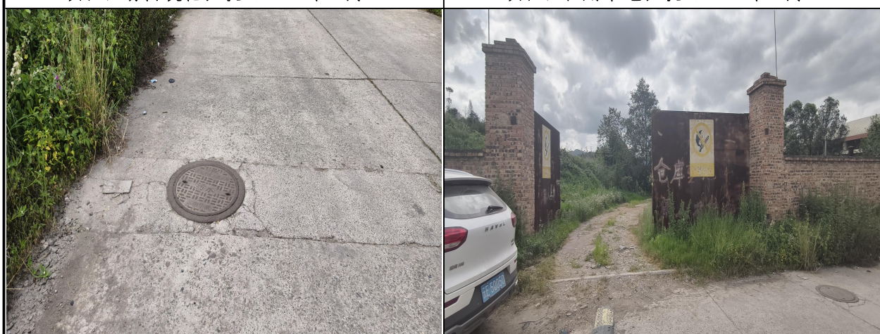
连接道路市政雨污管网（2024年7月）
