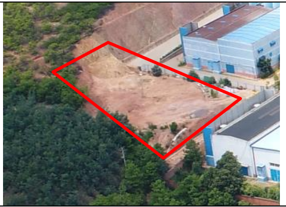
新建制氧站现状
