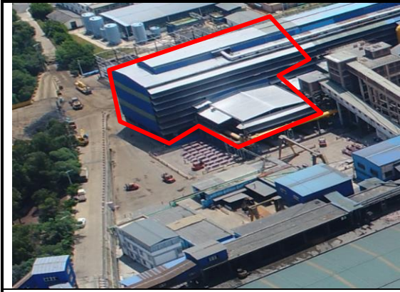
阳极炉工段拆除及转炉改造区域现状
