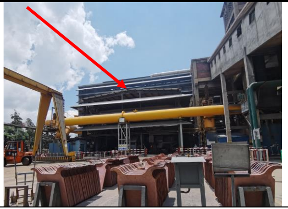
阳极炉工段将拆除建筑物现状
