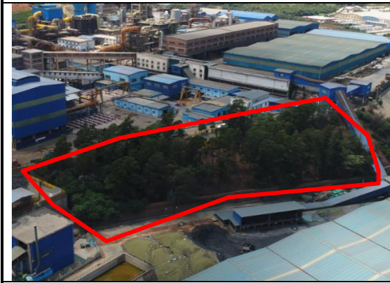
需要硬化处理边坡现状
