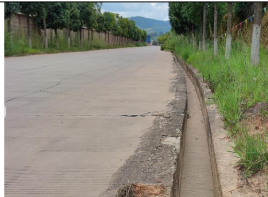
项目区北侧现有道路边沟现状
